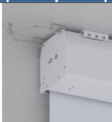
FISSAGGIO SISTEMA DI SICUREZZA
